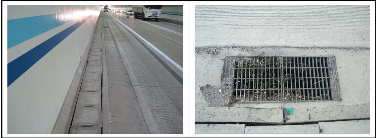
【사진 5.3.9】 공동구 및 배수시설 전경
