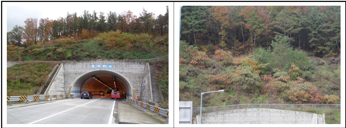
【사진 5.3.21】 사면 전경
