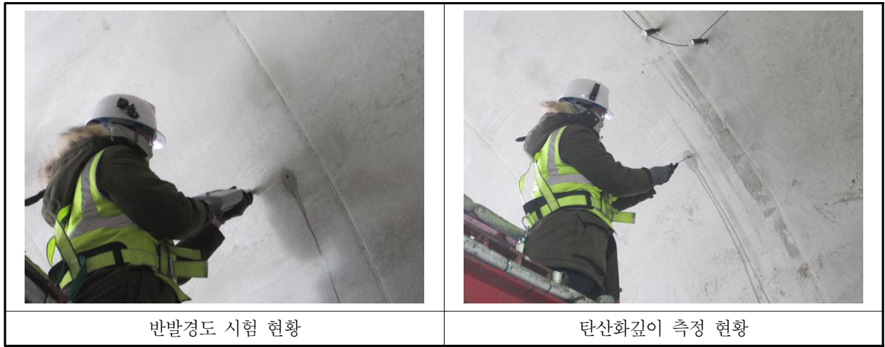
【사진 5.4.1】 콘크리트 내구성조사 현황
