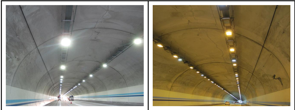
【사진 5.3.1】 라이닝 천단부 전경
