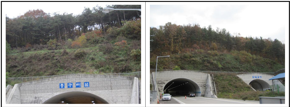
【사진 5.3.7】 사면 전경
