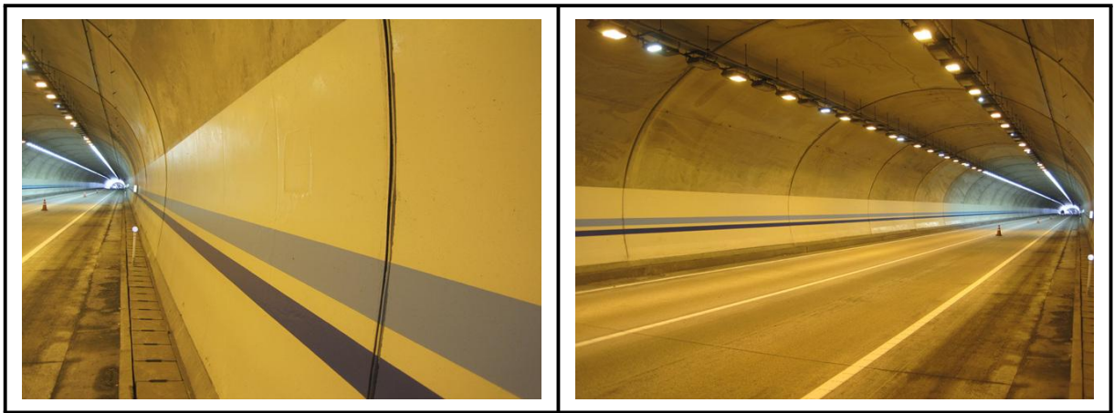
【사진 5.3.17】 라이닝 측벽부 전경
