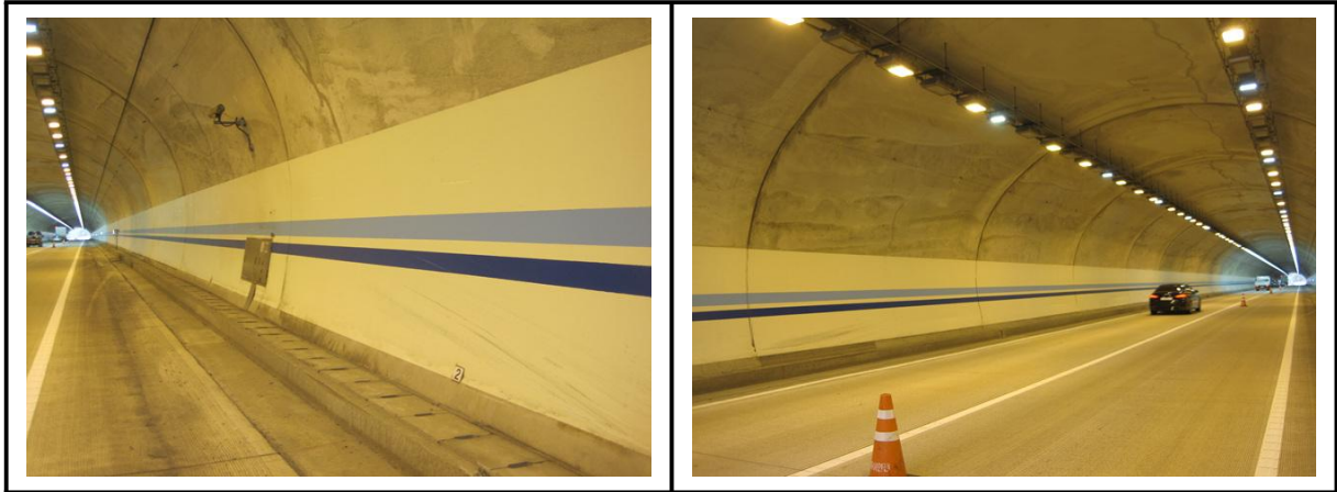
【사진 5.3.3】 라이닝 측벽부 전경
